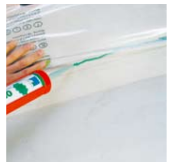
Aansluiting van de damprem op een kraagplaat met pro clima ORCON F.
