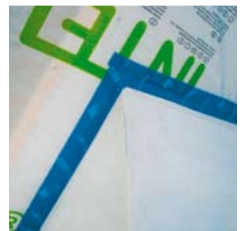
Aansluiting van de damprem op gladde, porievrije, niet gepolijste schoorstenen uit geprefabriceerde elementen met pro clima TESCON PROFIL.
