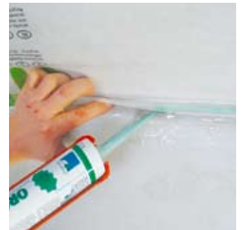
Aansluiting van de damprem op een bepleisterde schoorsteen met pro clima ORCON F.
